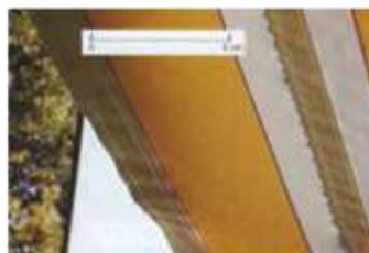
DILATACIÓN DE LAS BANDAS LATERALES
